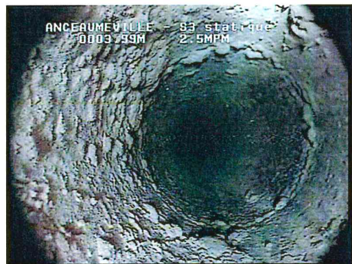
Tube lisse recouvert d'une incrustation irrégulière et hétérogène
