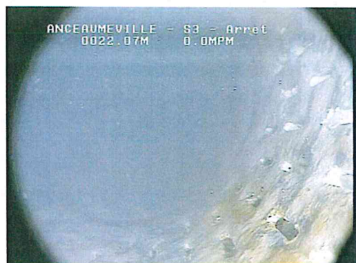
Arrivées d'eau (EN STATIQUE) avec venues de particules de craie au travers de certaines fentes
