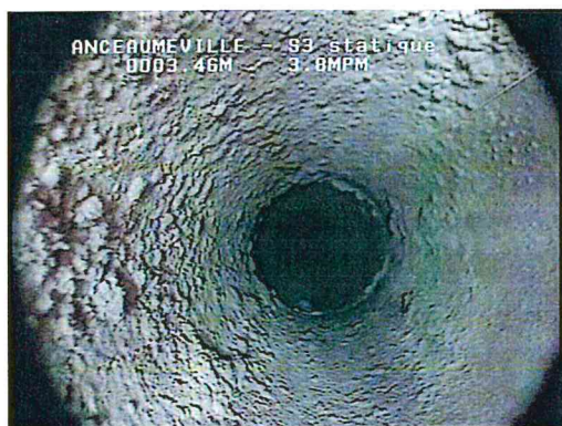
Tube lisse recouvert d'une incrustation irrégulière et hétérogène
