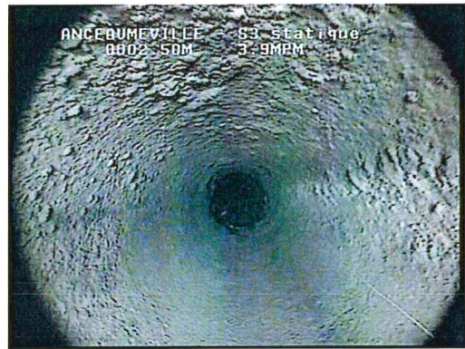
Tube lisse recouvert d'une incrustation irrégulière et hétérogène
