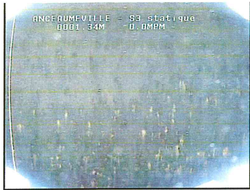
Tube lisse recouvert d'une incrustation irrégulière et hétérogène
