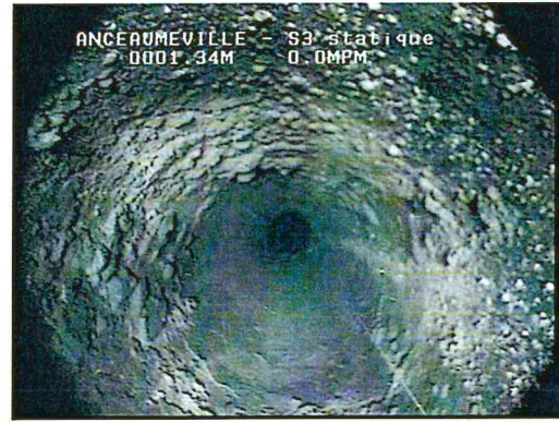
Tube lisse recouvert d'une incrustation irrégulière et hétérogène
