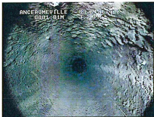
Tube lisse recouvert d'une incrustation irrégulière et hétérogène
