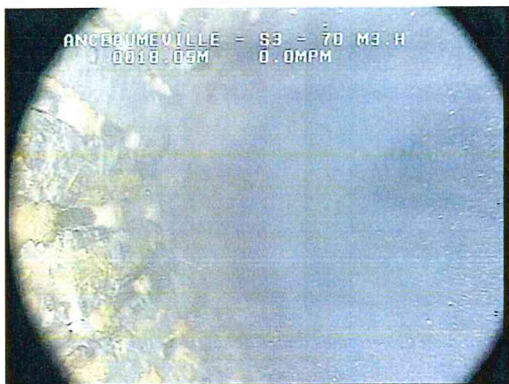
Colonne d'eau « centrale » chargée en turbidité avec venues d'eau claire depuis l'ensemble de la crépine, avec particules de craie en suspension, qui diminuent avec le temps de pompage
